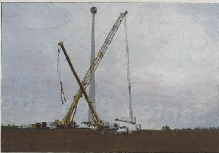
Les pâles des éoliennes sont assemblées mais le vent empêche de les lever.
