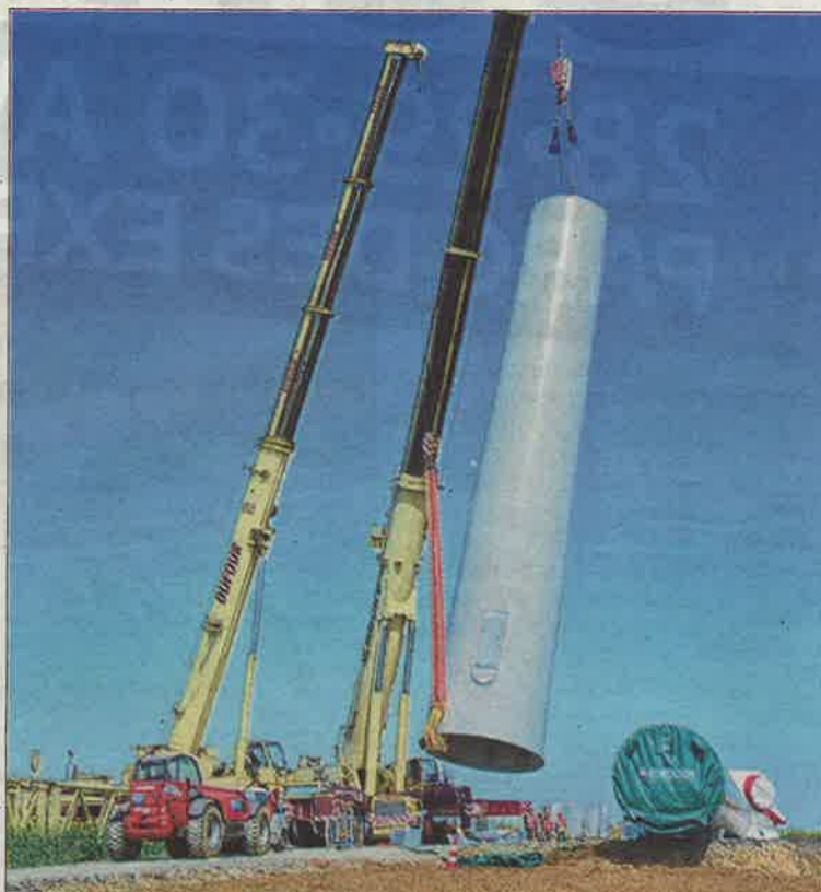
Le montage commence par le positionnement du mat à fixer au sol sur les fondations.
