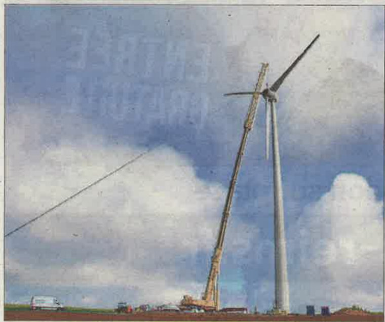
La dernière pièce à assembler reste le capot.
